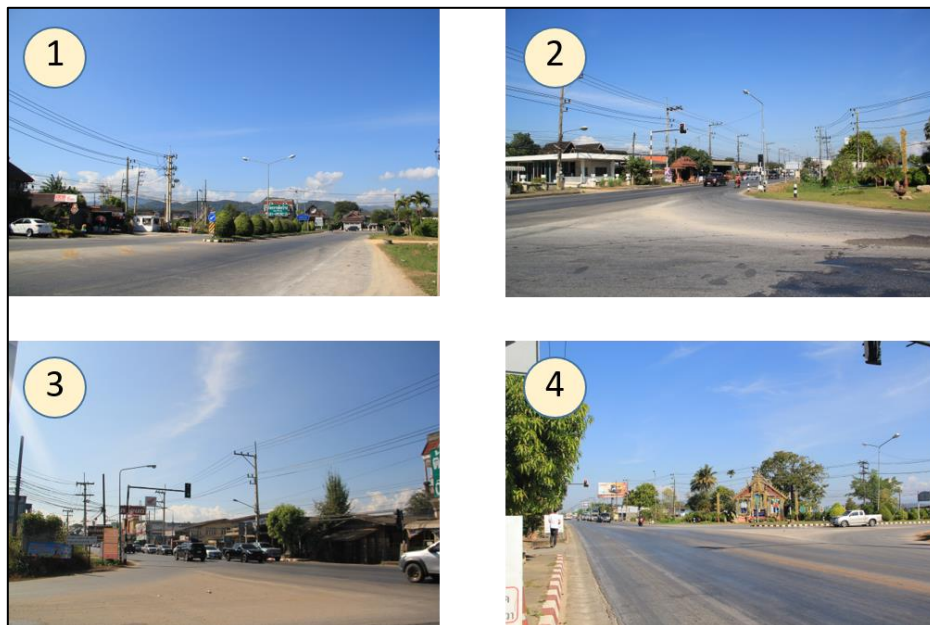
รูปที่ 5-11 สภาพพื้นที่ทางแยกจุดตัดทางหลวงหมายเลข 118 (จุดสิ้นสุดโครงการ)
